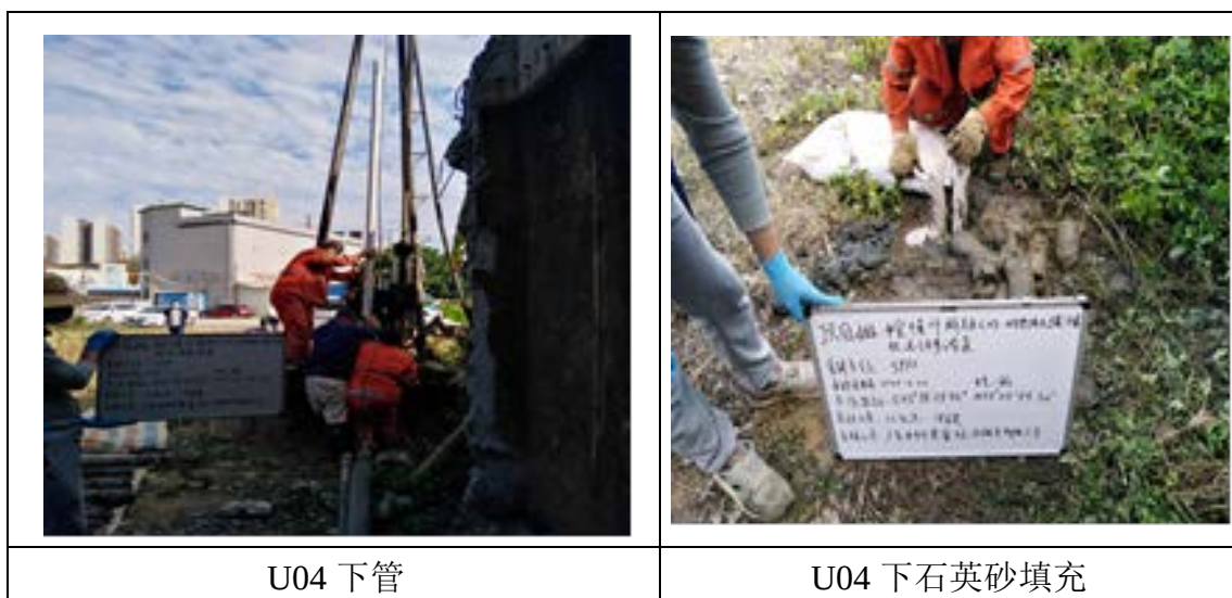
图 5.1-5 地下水初次采样监测井的建井与洗井照片
