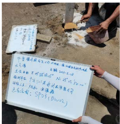
DW02 下膨润土封隔
