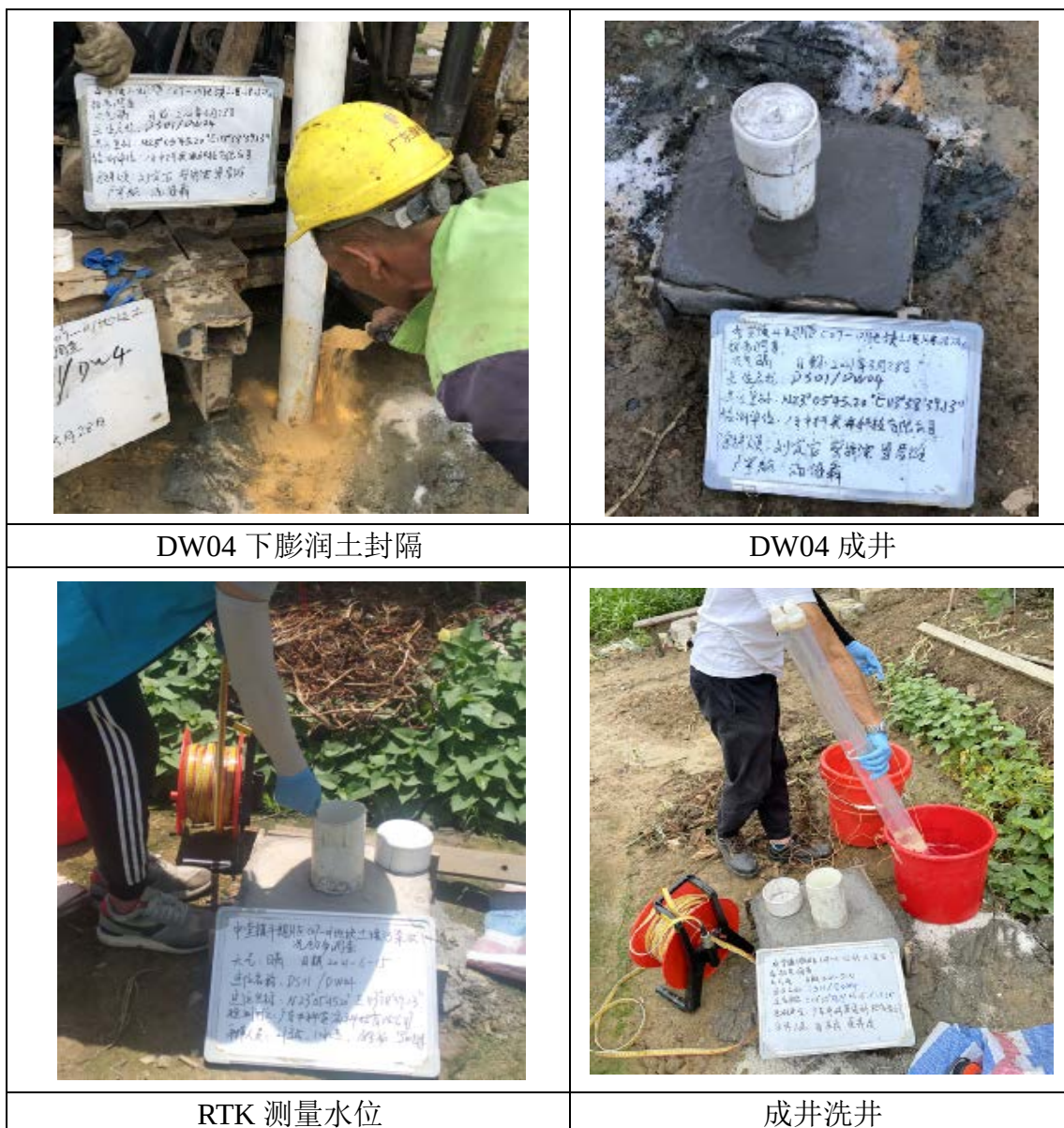
图 5.1-5 地下水初次采样监测井的建井与洗井照片
