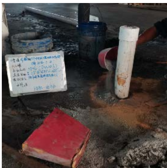
DW03 下膨润土封隔
